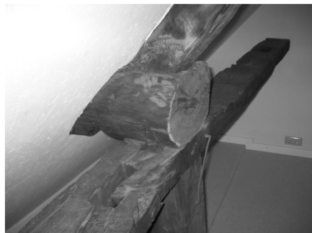
Abbildung 3: (a) Balken 5a mit durchgehender Nut und größeren Ausnehmungen, (b) Balkenstummel des siebten Gebindes mit doppeltem Kamm und wiederverwendetem Sparrenpott. Auch das Rähm stammt aus der Wiederverwendung; dort, wo es aufgrund eines durchgestemmt Zapfenloches geschwächt war, ist es gebrochen.
