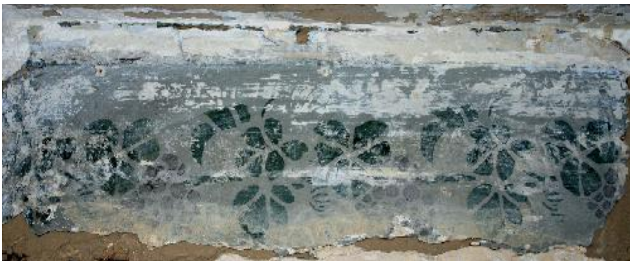
Sicherungsklebung mit Knochenleim für die Putzabnahme
