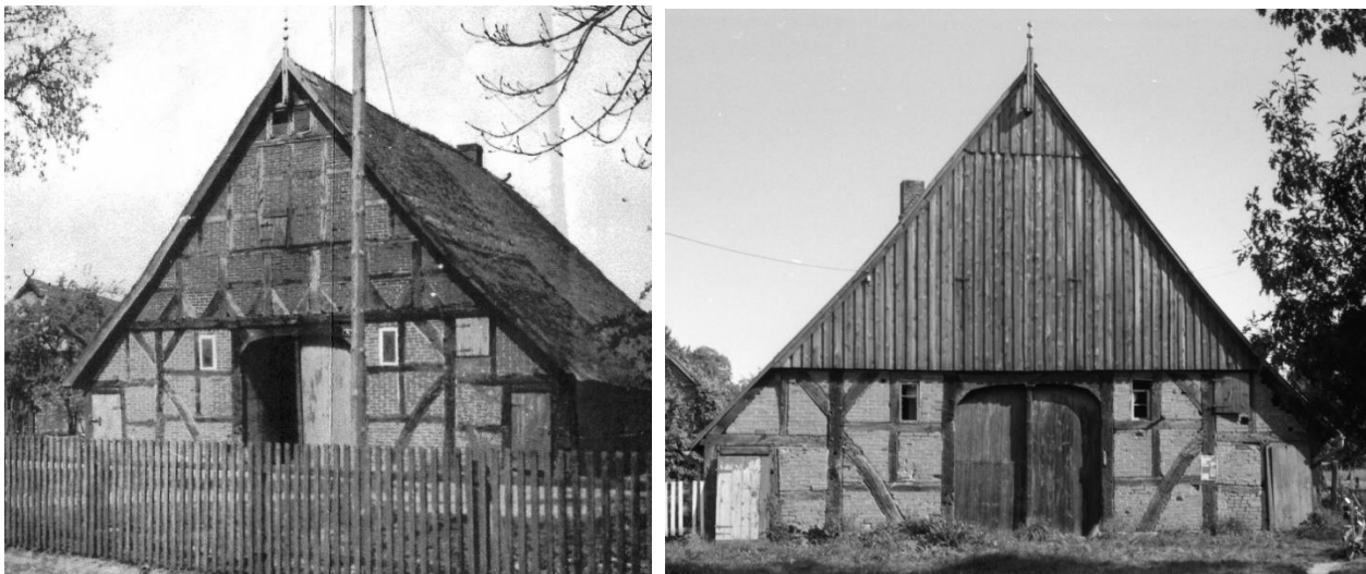
Abbildung 2: Zwei historische Fotos des Wirtschaftsgiebels. Auf dem linken Bild ist gut der Absatz zwischen altem Giebeltrapez und aufgesetzter Fachwerkwand erkennbar. Alter und Herkunft der linken Abbildung sind unbekannt. Das rechte Foto stammt von C.I. Johannsen aus dem Jahr 1972.
