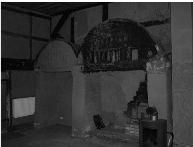
Abbildung 4: (a) Doppelschwibbogen im Bereich des Flett, Zustand 2011, (b) Aufnahme der gleichen Situation aus dem Jahr 1972, Foto C.I. Johannsen.
