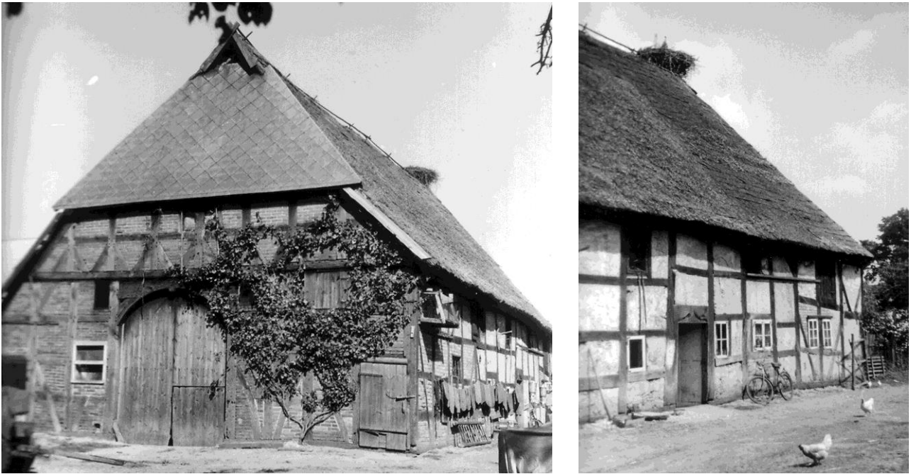
Abbildung 2: Zwei historische Fotos aus dem Archiv Bruno zu Jeddelloh (Museumsdorf Hösseringen; Datum der Aufnahmen unbekannt; vermutlich um 1960). (a) zeigt das Tor vor dem Entfernen der Kopfbänder, (b) die hohe Traufseite mit dem „Eselrücken“ als Türriegel am Beginn der Lucht.
