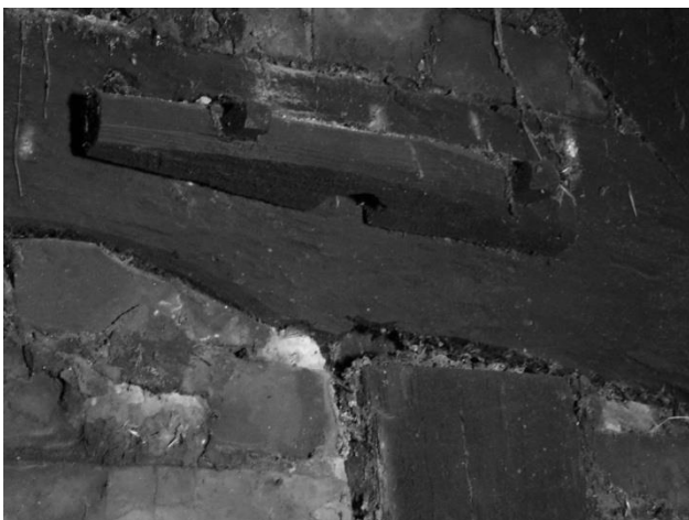
Abbildung 4: (a) Reste der Aufnahmen ehemals vorhandener Klappen hinter den Öffnungen im oberen Teil des Wirtschaftsgiebels, (b) Untere Aufnahme mit Mulde, (c) Obere Aufnahme mit durchgehendem Loch, (d) Rekonstruktion.
