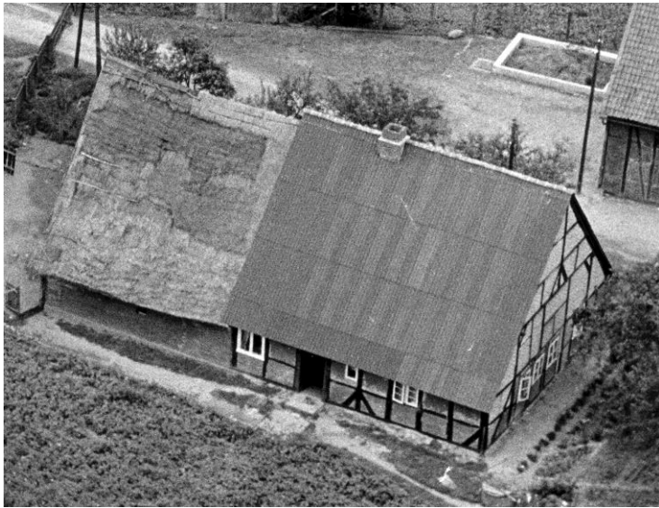
Abbildung 3: (a) Detail eines Luftbildes von 1956. Erkennbar ist unter anderem der Wohngiebel vor dem Ersetzen des Fachwerks im Erdgeschossbereich, (b) Rekonstruktion des Zustandes von 1956 auf der Grundlage des nebenstehenden Fotos. Erkennbar sind Doppelstiele zwischen den Fensteröffnungen und zwei verschiedene Deckenhöhen, ablesbar an den Balkenköpfen. Auch die konstruktive Einbindung ist unterschiedlich.
