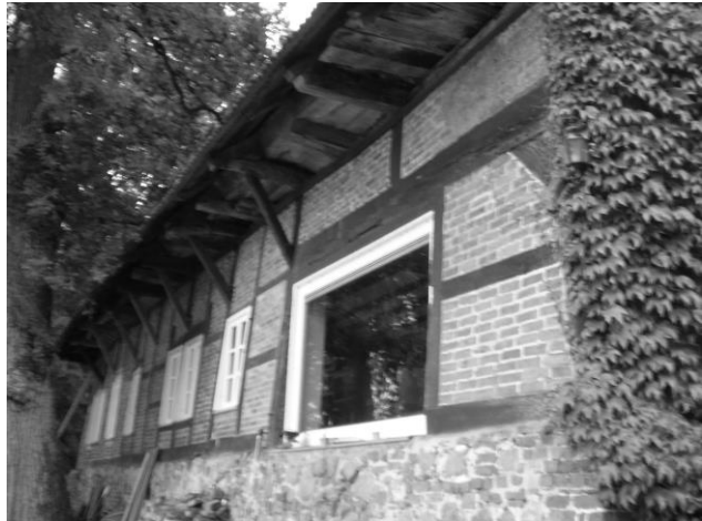
Abbildung 1: (a) Wohngiebel mit Füllhölzern und vorgehängten Knaggen. (b) Luchtriegel der nördlichen Dielenwand, heute Außenwand. (Fotos: Wübbenhorst, 2011)
