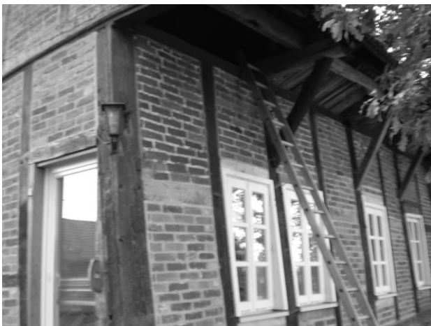
Abbildung 2: (a) Erheblicher Balkenüberstand an der nördlichen Dielenwand mit äußeren Kopfbändern. (b) Südtraufe mit Giebelerker. (Fotos: Wübbenhorst, 2011)
