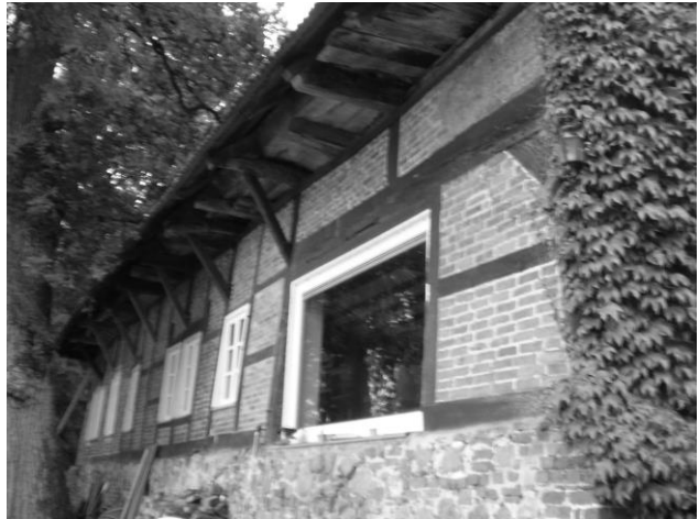
Abbildung 1: (a) Wohngiebel mit Füllhölzern und vorgehängten Kragbalken. (b) Luchtriegel der nördlichen Dielenwand, heute Außenwand. (Fotos: Wübbenhorst, 2011)
