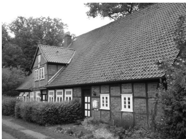
Abbildung 2: (a) Erheblicher Balkenüberstand an der nördlichen Dielenwand mit äußeren Kopfbändern. (b) Südtraufe mit Giebelerker. (Fotos: Wübbenhorst, 2011)
