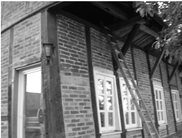
Abbildung 2: (a) Erheblicher Balkenüberstand an der nördlichen Dielenwand mit äußeren Kopfbändern. (b) Südtraufe mit Giebelkerker. (Fotos: Wübbenhorst, 2011)
