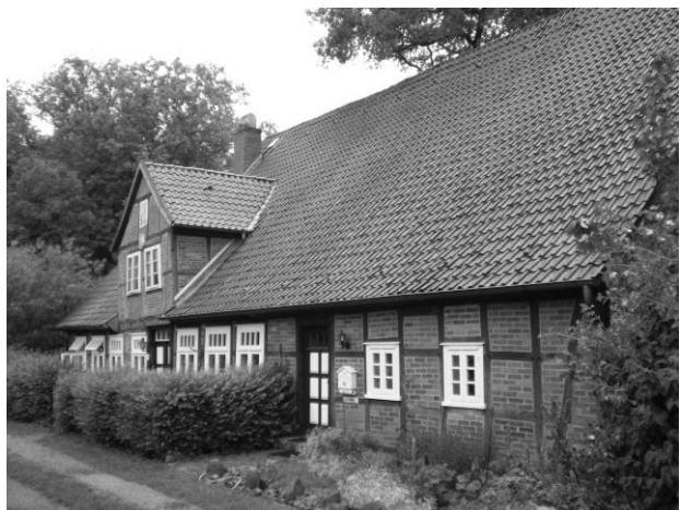
Abbildung 2: (a) Erheblicher Balkenüberstand an der nördlichen Dielenwand mit äußeren Kopfbändern. (b) Südtraufe mit Giebelkerker. (Fotos: Wübbenhorst, 2011)
