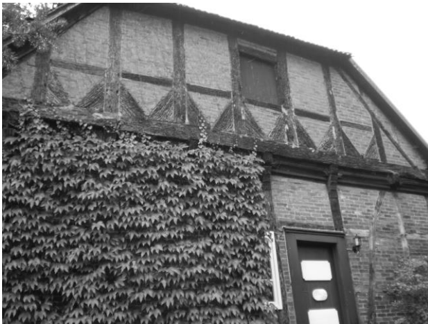
Abbildung 1: (a) Wohngiebel mit Füllhölzern und vorgehängten Kragbalken. (b) Luchtriegel der nördlichen Dielenwand, heute Außenwand. (Fotos: Wübbenhorst, 2011)
