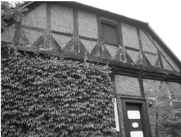
Abbildung 1: (a) Wohngiebel mit Füllhölzern und vorgehängten Knaggen. (b) Luchtriegel der nördlichen Dielenwand, heute Außenwand. (Fotos: Wübbenhorst, 2011)
