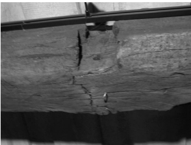
Abbildung 2: (a) Wohngiebel, (b) Kopfbandblattsasse an Balken III, N-Seite. Die Verschiebung des späteren, eingezapften Kopfbands nach innen ist deutlich erkennbar, (c) Blattsasse mit doppeltem Schwalbenschwanz am Balken III, (d) Erstverwendungsspuren an einem wiederverwendeten Deckenbalken
