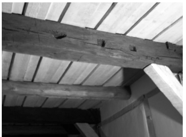
Abbildung 2: (a) Wohngiebel, (b) Kopfbandblattsasse an Balken III, N-Seite. Die Verschiebung des späteren, eingezapften Kopfbands nach innen ist deutlich erkennbar, (c) Blattsasse mit doppeltem Schwalbenschwanz am Balken III, (d) Erstverwendungsspuren an einem wiederverwendeten Deckenbalken
